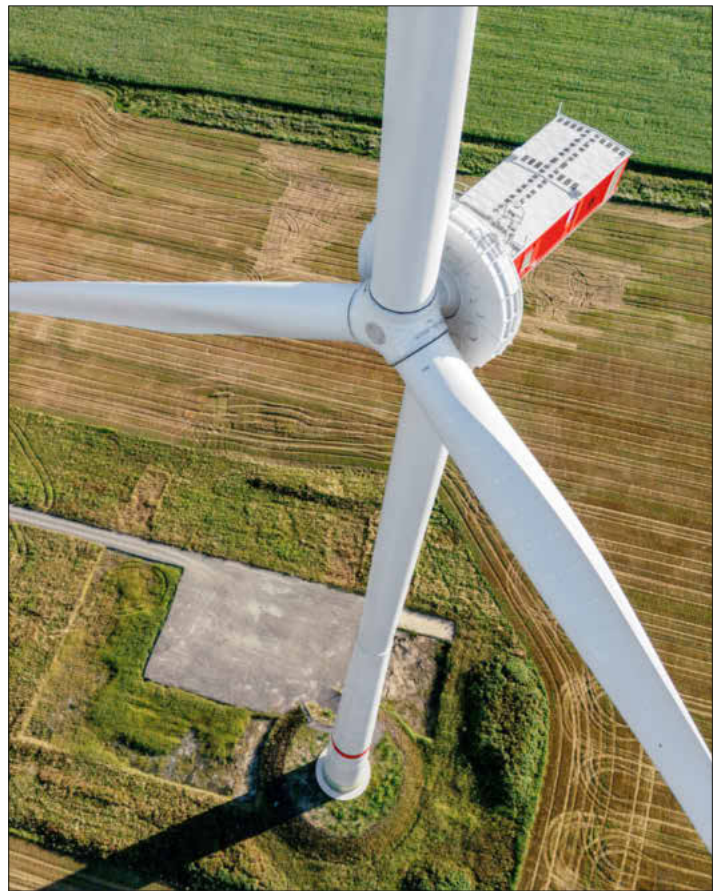
Dieser Anlagentyp soll auf der Platte aufgestellt werden. FOTO: ENERCON GMBH
